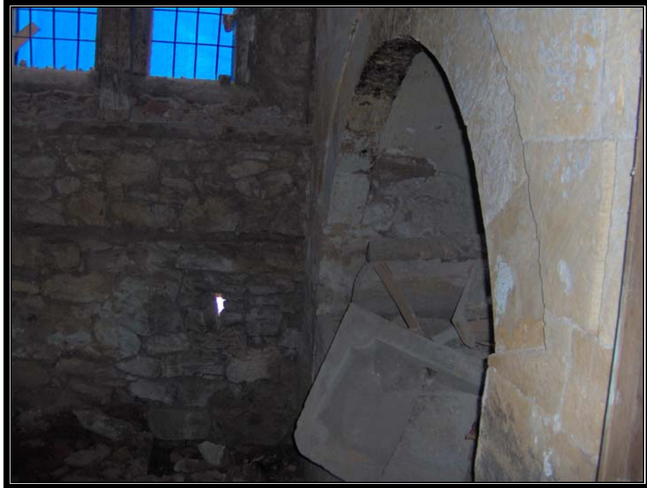
Resim.3.4.20 Hayri İnal Konağı mutfaktan bir görünüş
