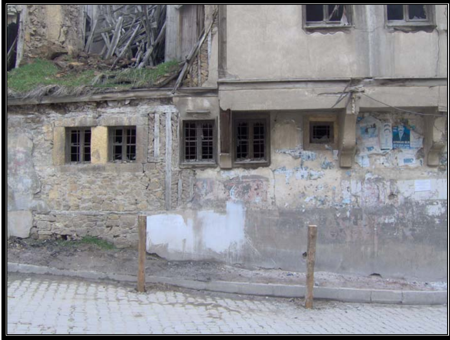
Resim.3.4.7 Hayri İnal Konağı zemin katında pencere görünüşü
