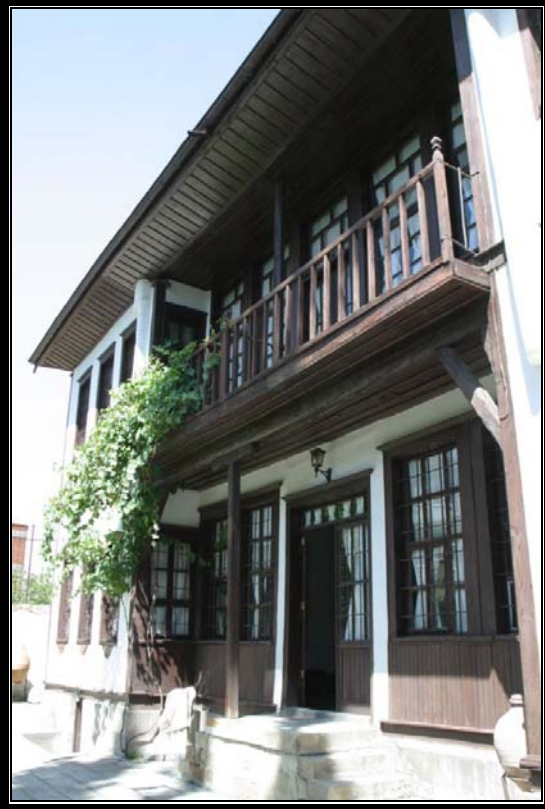
Resim.3.1.2 Nizamoğlu konağının güney cephesinden görünüşü
