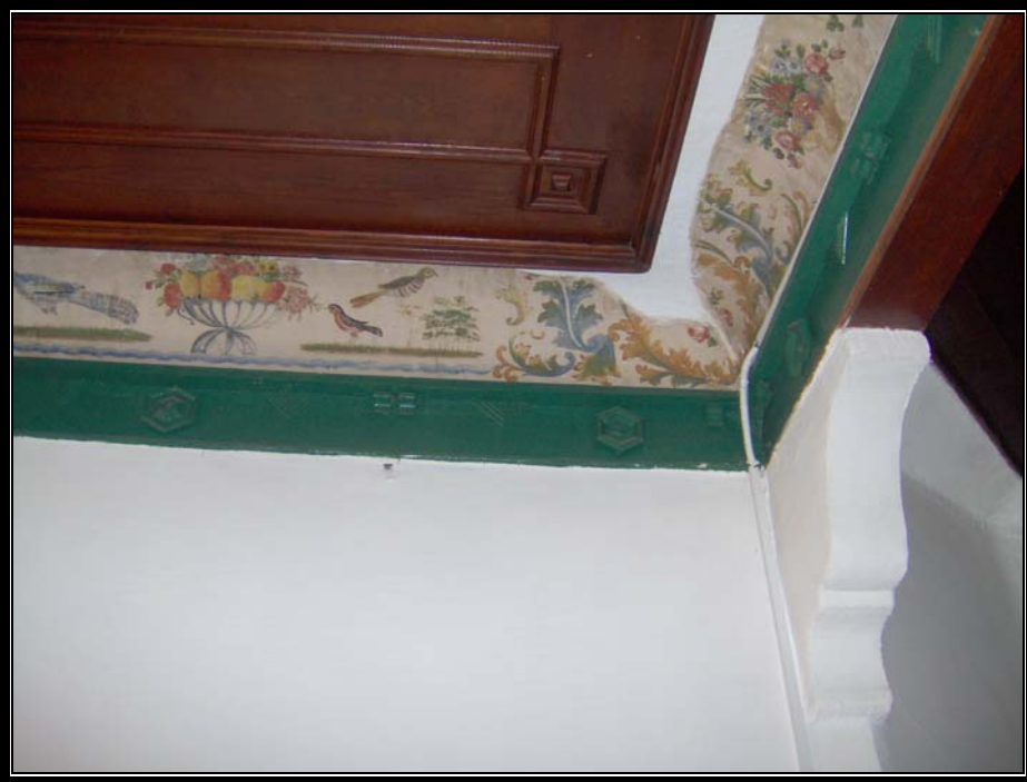
Resim.3.1.36 1. kat sofanın tavan köşe birleşim detayı
