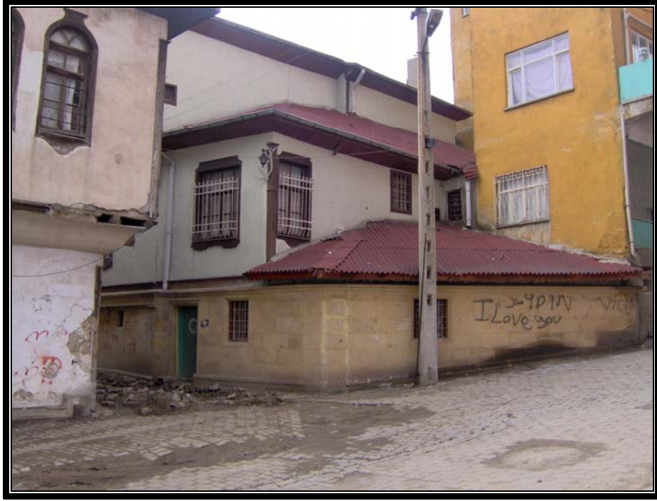
Resim.3.3.3 Divanlıoğlu konağının kuzey doğu cephesinden bir görünüş
