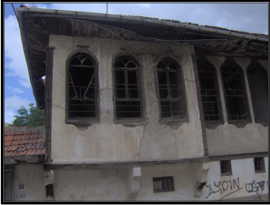
Resim.3.5.5 Koldemir konağı cephesinde çıkma görünüşü
