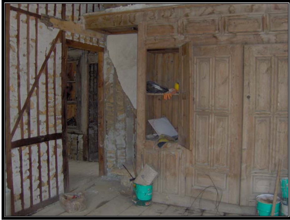
Resim.3.4.27 Hayri İnal Konağı 1. kat güney doğudaki odanın giriş görünüşü
