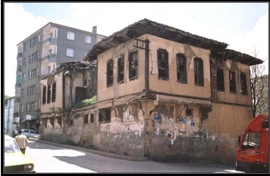
Resim.3.4.4 Hayri İnal Konağı kuzey batı cephesinden bir görünüş
