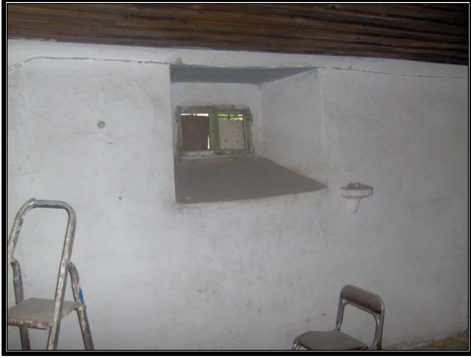
Resim.3.5.11 Koldemir konağı güney batıdaki odada pencere görünüşü
