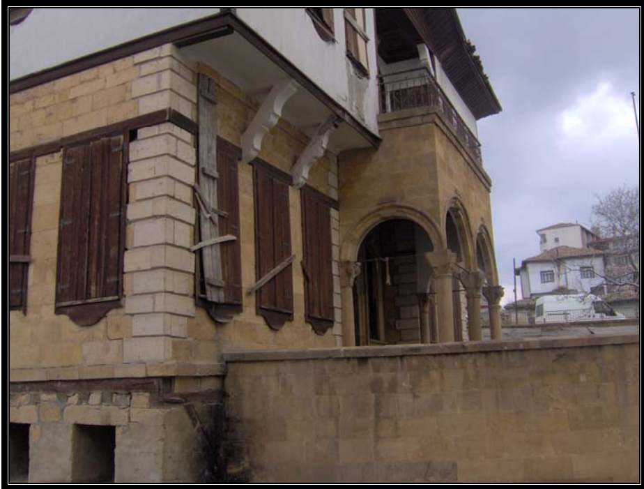
Resim.3.2.4 Karşıoğlu konağında taş kaplama görünüşü
