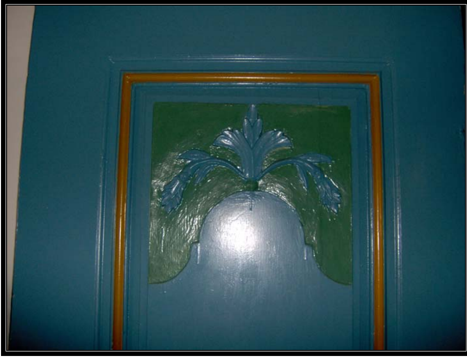
Resim.3.1.57 1.kat oda giriş kapıları üzerindeki süslemeler
