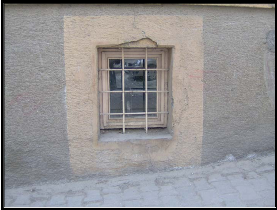
Resim.3.6.10 Miralay konağı zemin kat pencere görünüşü
