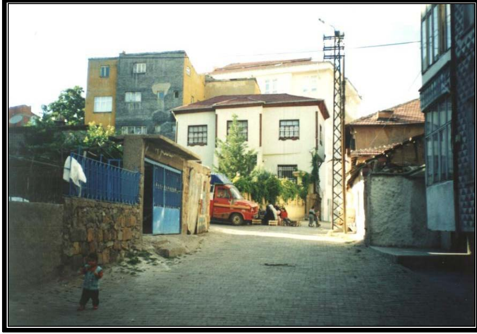
Resim.3.3.1 Divanlıoğlu konağı güney cephesinden bir görünüş
