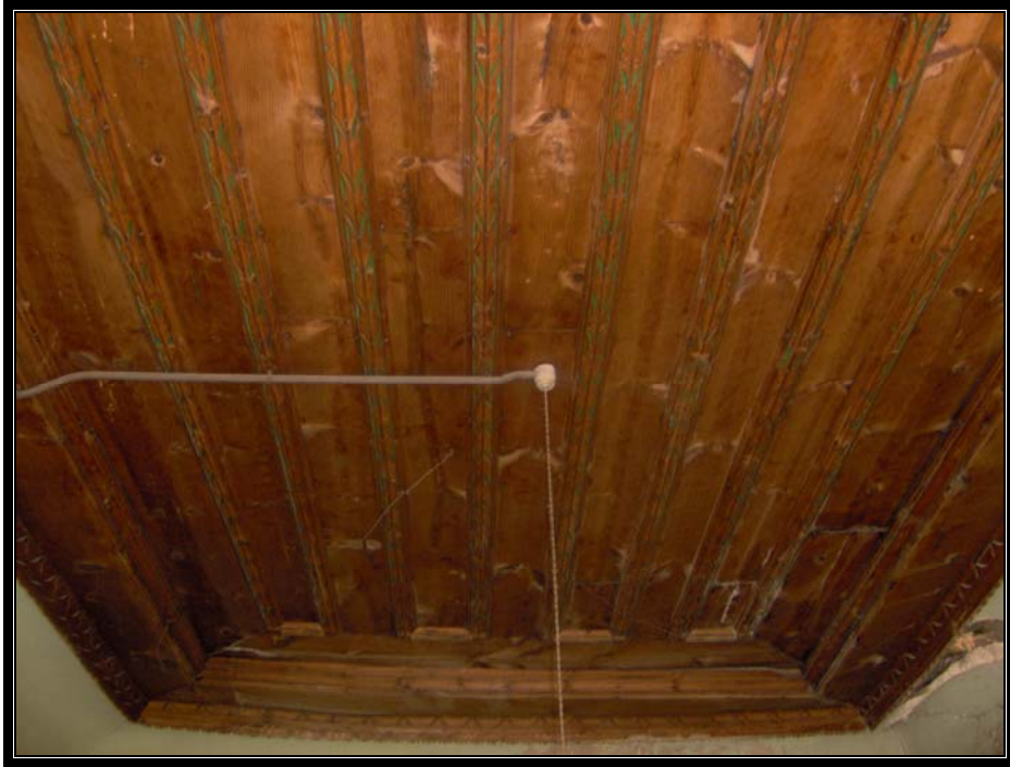
Resim.3.5.16 Koldemir konağı 1.kat güney doğudaki odanın tavanından bir görünüş
