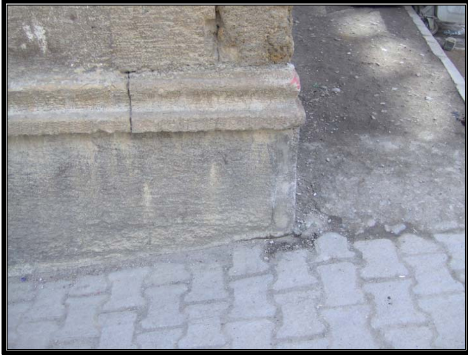
Resim.3.6.7 Miralay konağı dış cephesinde köşe birleşim görünüşü
