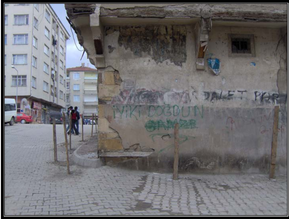
Resim.3.4.8 Hayri İnal Konağı zemin kat duvarlarından bir görünüş
