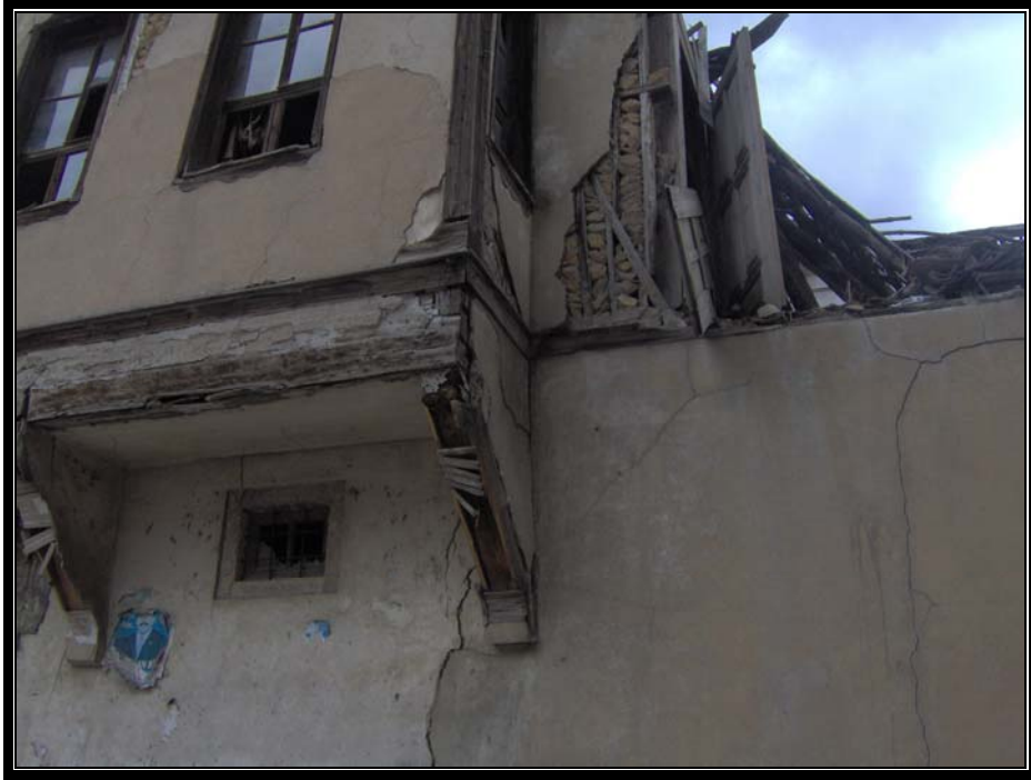
Resim.3.4.6 Hayri İnal Konağında çıkma ve eliböğünde görünüşü
