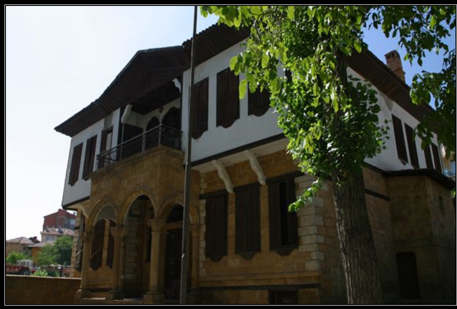
Resim.3.2.2 Karşıoğlu konağı güney cepheden bir görünüş
