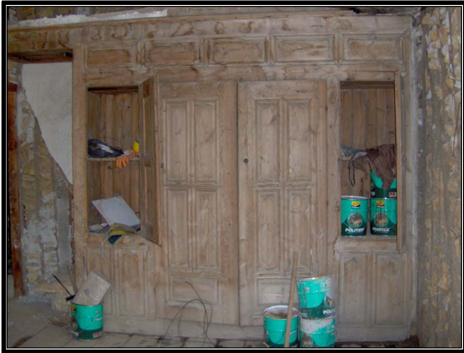
Resim.3.4.26 Hayri İnal Konağı 1.kat güney doğudaki odadaki dolap görünüşü
