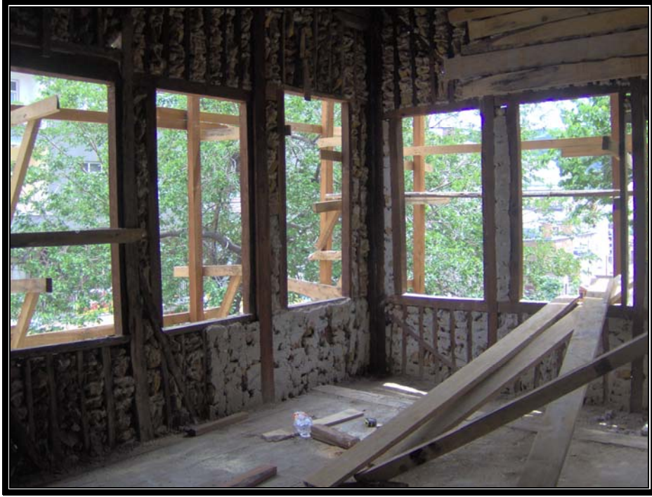
Resim.3.4.25 Hayri İnal Konağı güney doğudaki odadan bir görünüş
