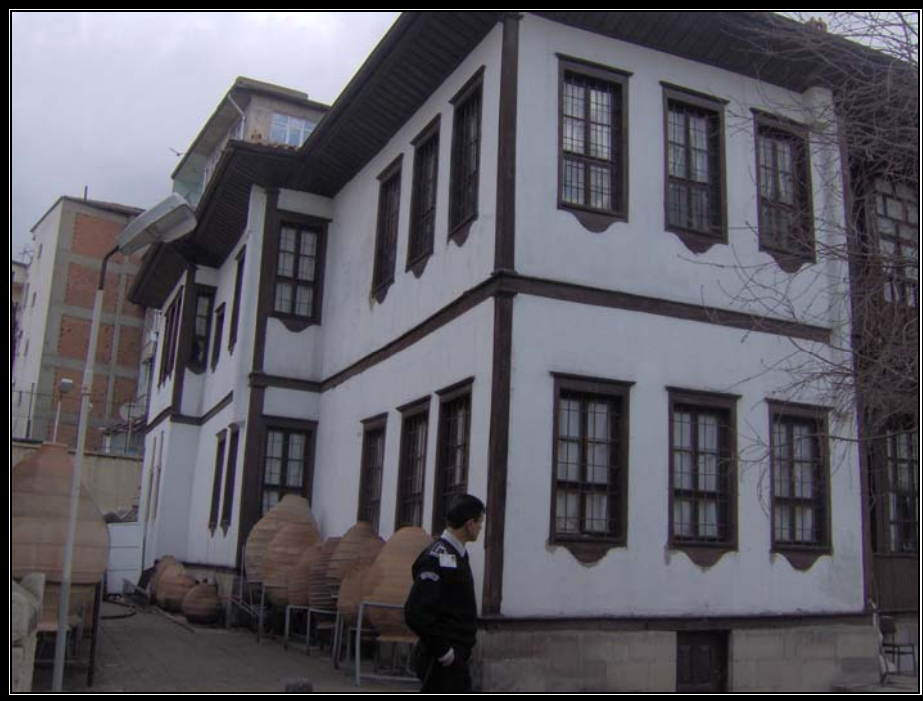
Resim.3.1.4 Nizamoğlu konağının batı cephesinden görünüşü
