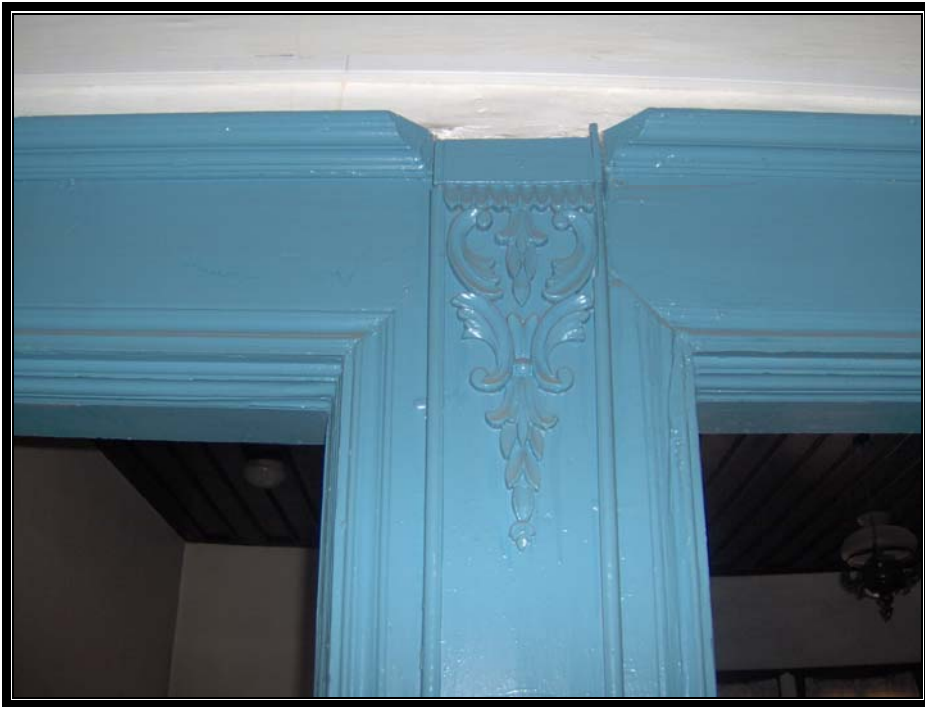
Resim.3.1.58 1.kat oda giriş kapıları üzerindeki süslemeler
