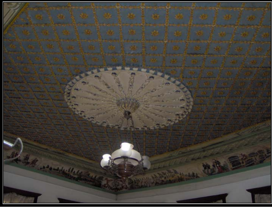
Resim.3.1.45 1.kat güney batıdaki odanın tavan görünüşü
