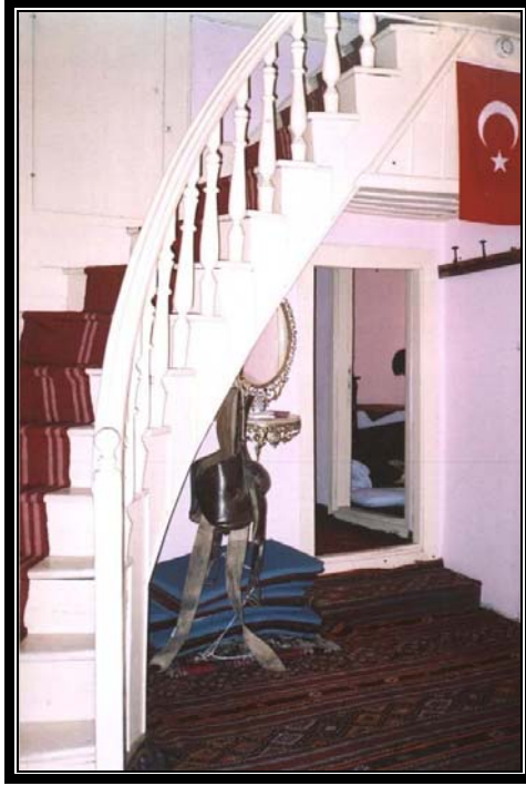
Resim.3.3.7 Divanlıođlu konađının üst kat ıkış merdiveni
