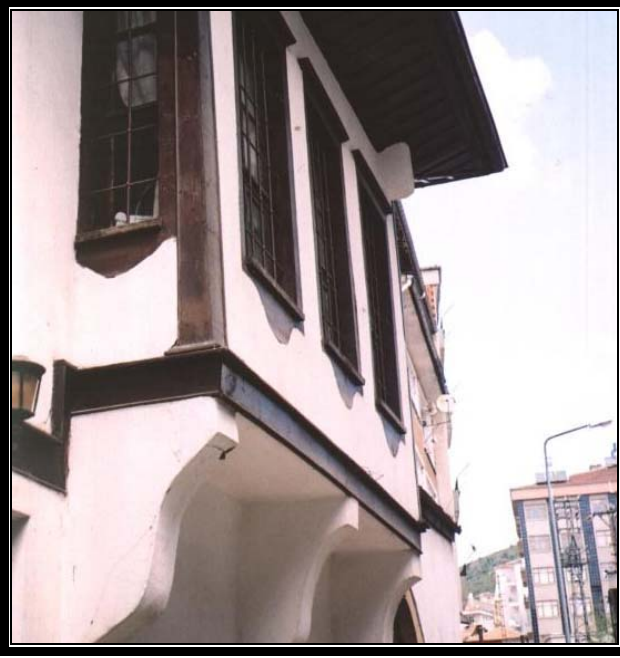
Resim.3.1.5 Nizamoglu konağında cephe çıkmalarından görünüş
