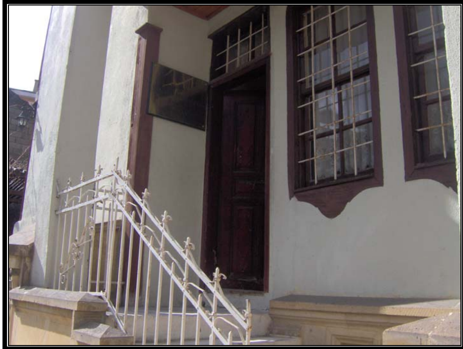
Resim.3.3.6 Divanlıođlu konađının giriř kapısı
