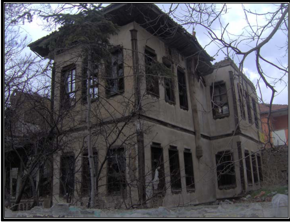
Resim.3.4.3 Hayri İnal Konağı doğu cephesinden bir görünüş
