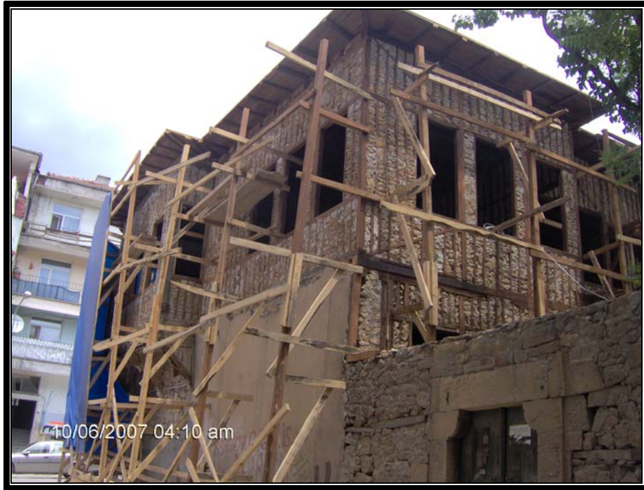
Resim.3.4.10 Hayri İnal Konağı batı cephesinden bir görünüş
