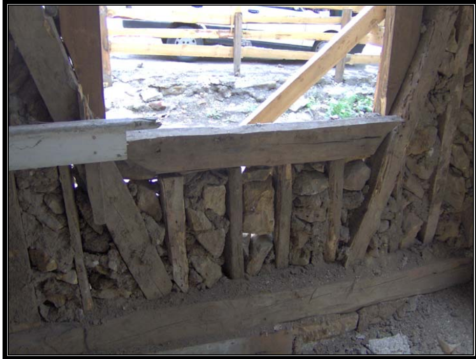
Resim.3.4.18 Hayri İnal Konağı güney doğudaki odada duvar yapım tekniği
