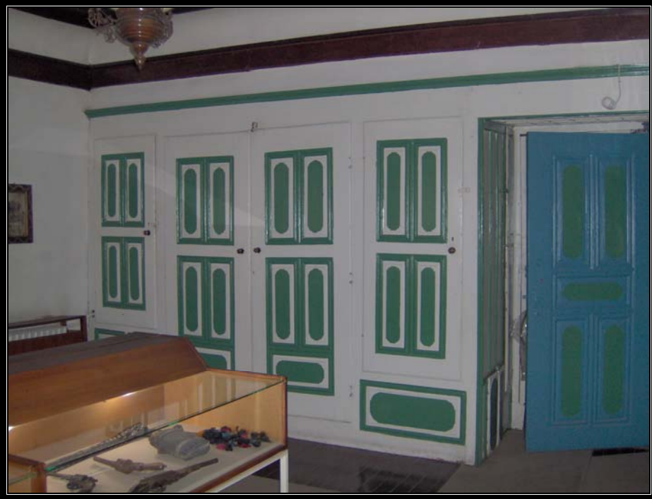
Resim.3.1.18 Güney batıdaki odanın dolap görünüşü
