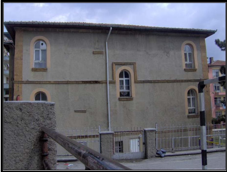
Resim.3.6.4 Miralay konağı batı yönünden bir görünüş
