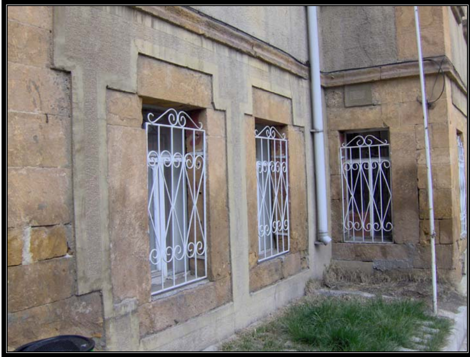
Resim.3.6.8 Miralay konağı zemin kat pencere görünüşü
