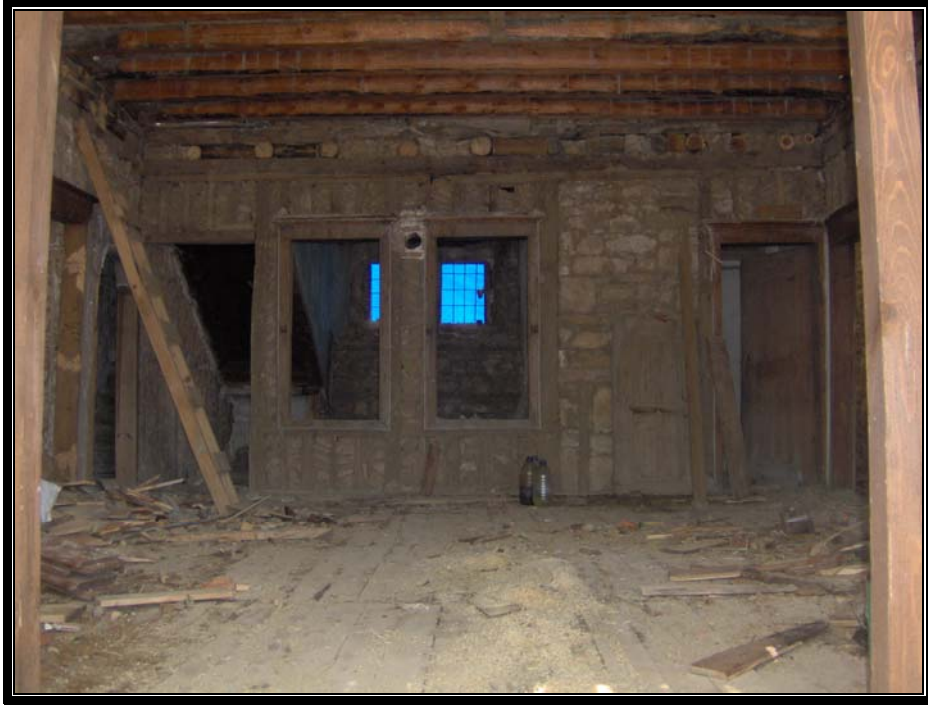
Resim.3.4.15 Hayri İnal Konağı zemin kat sofadan bir görünüş
