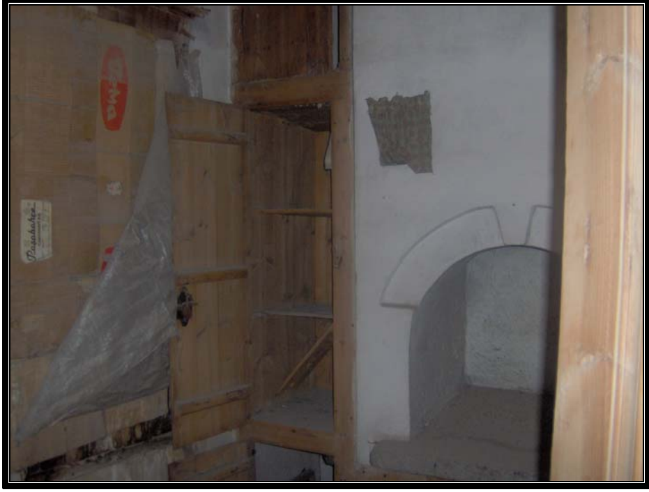
Resim.3.5.21 Koldemir konağı 1. kat mutfaktan bir görünüş
