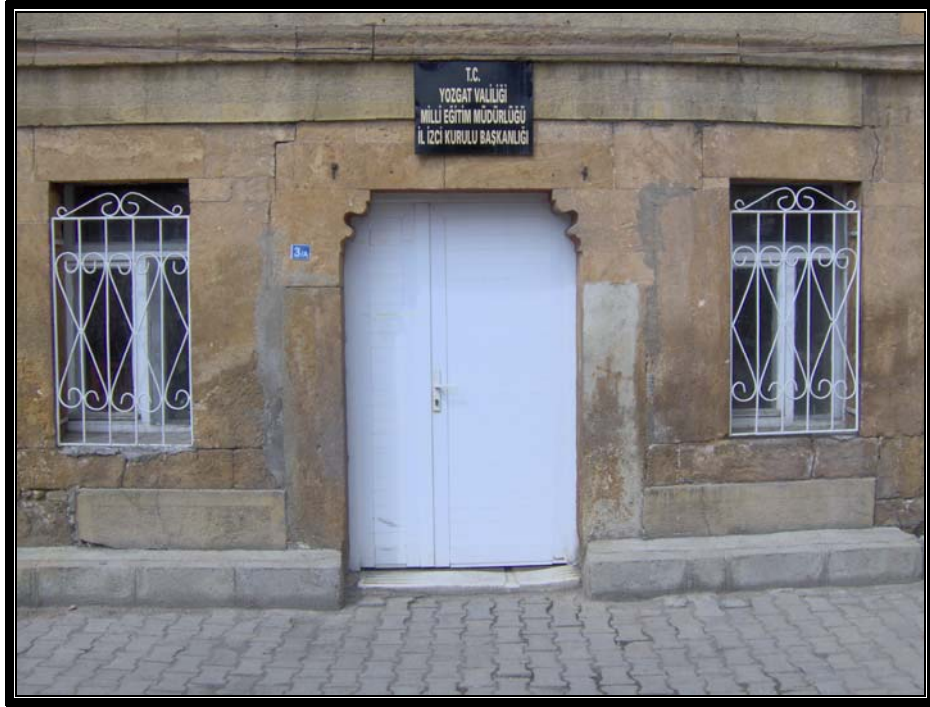
Resim.3.6.5 Miralay konağı giriş kapısından bir görünüş
