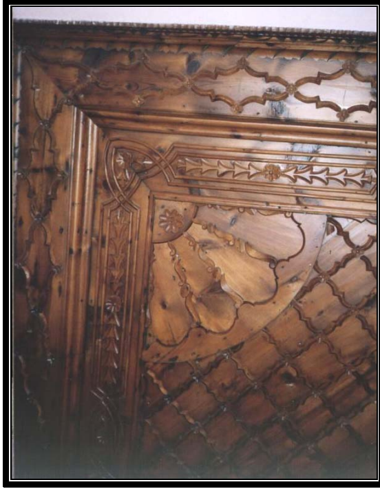
Resim.3.3.17 Divanlioğlu konağı 1. kat güney doğudaki odanın tavanında köşe birleşim görünüşü
