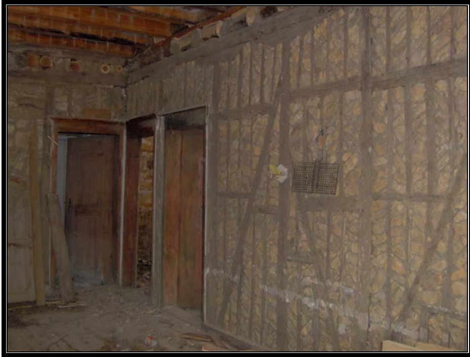
Resim.3.4.16 Hayri İnal Konağı iç duvarlardan bir görünüş
