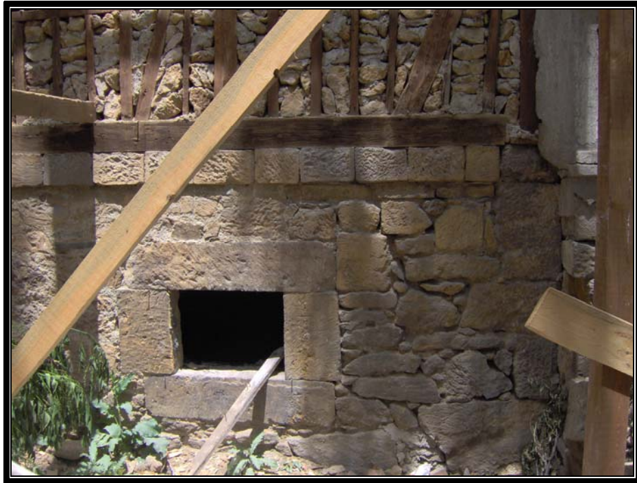
Resim.3.4.12 Hayri İnal Konağı bodrum kat duvar ve pencere görünüşü
