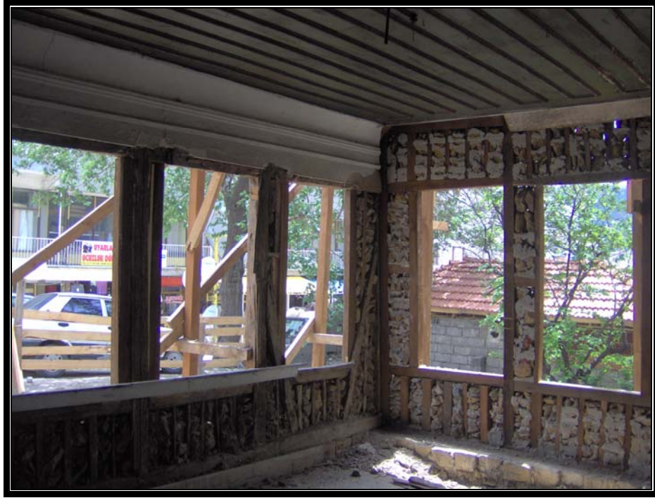
Resim.3.4.17 Hayri İnal Konağı güney doğudaki odadan bir görünüş
