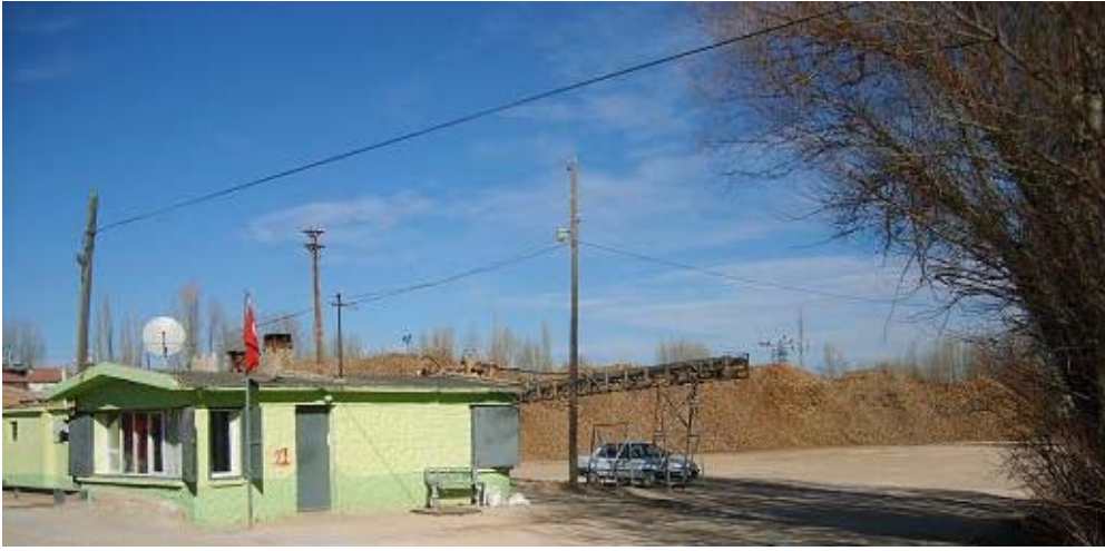
Şekil 6. Beyşehir Bölgesine Bağlı Üçpınar Tesellüm Merkezi
