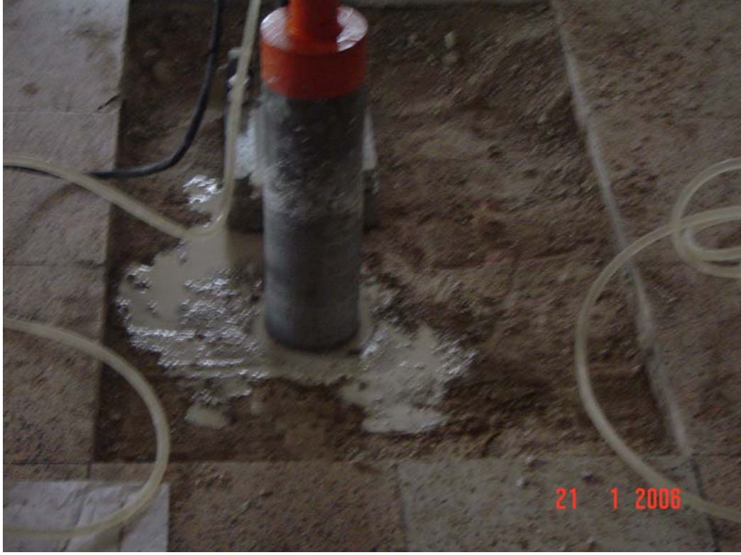
Resim 4.6. Normal kat döşemesinden karot alınması
