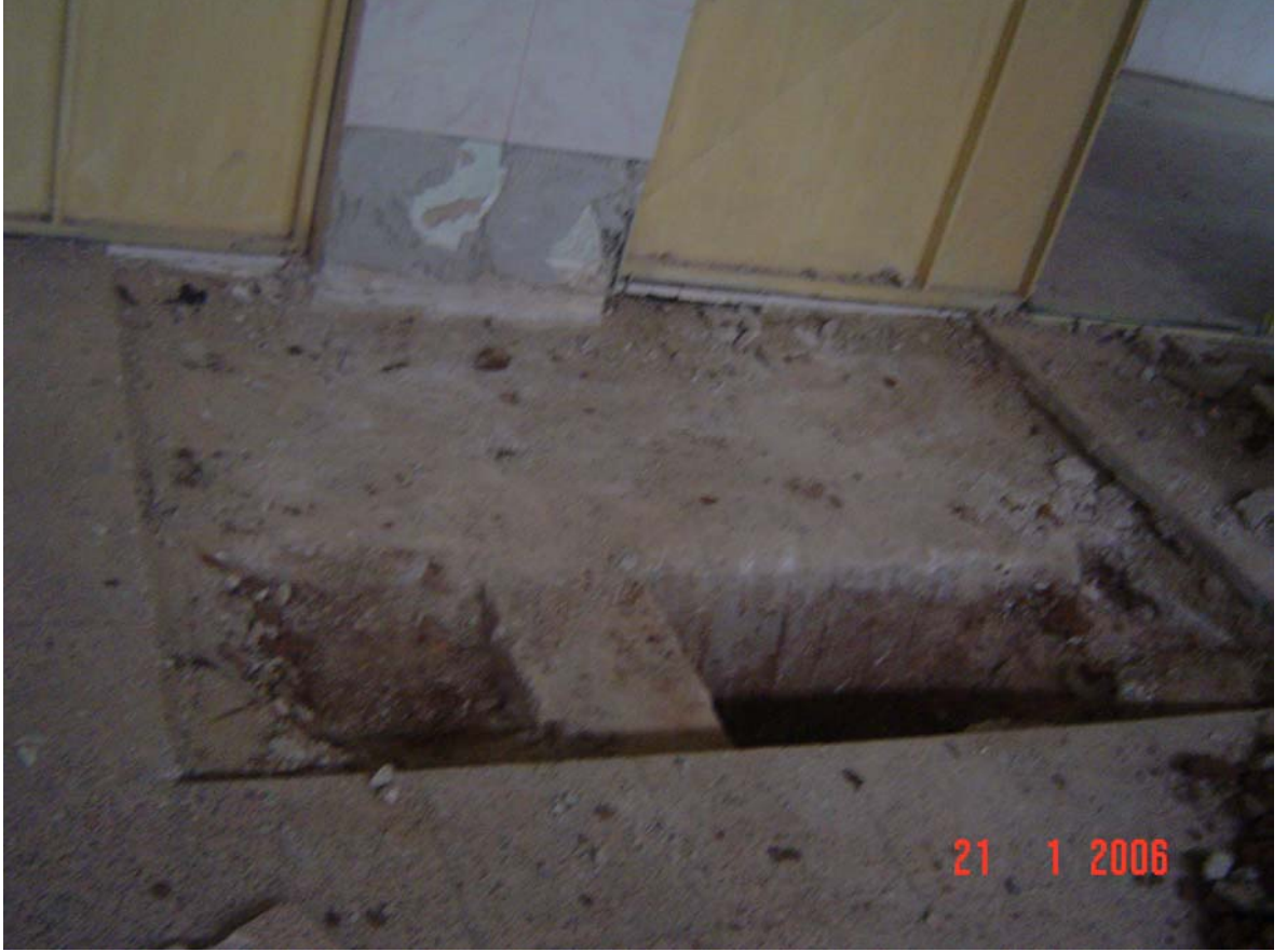
Resim 4.2. Temelde yapılan kazıya ait bir görüntü
