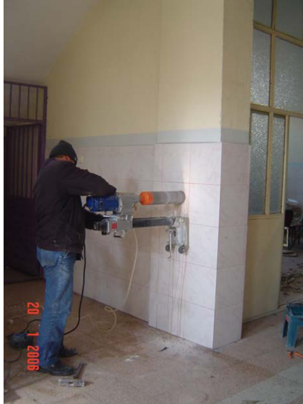
Resim 4.5. Bodrum kat SB14 kolonundan karot alınması
