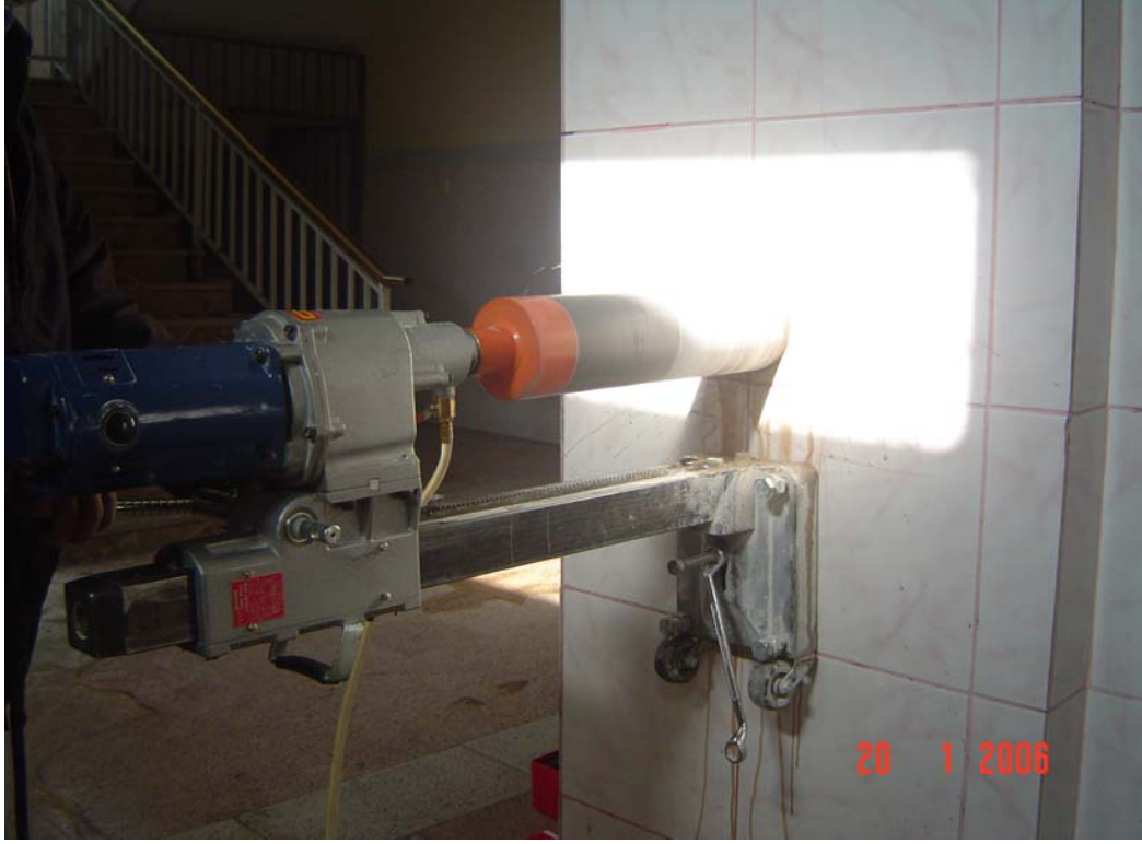
Resim 4.4. Bodrum kat SB24 kolonundan karot alınması
