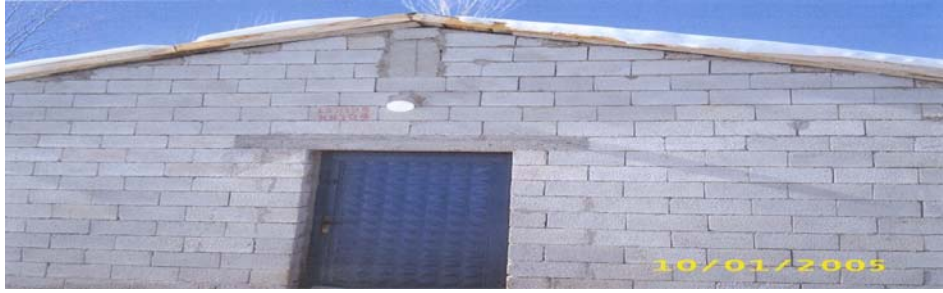
Şekil 4.3 Briket duvar malzemesi kullanılan barınağın görünümü(Adilcevaz)
