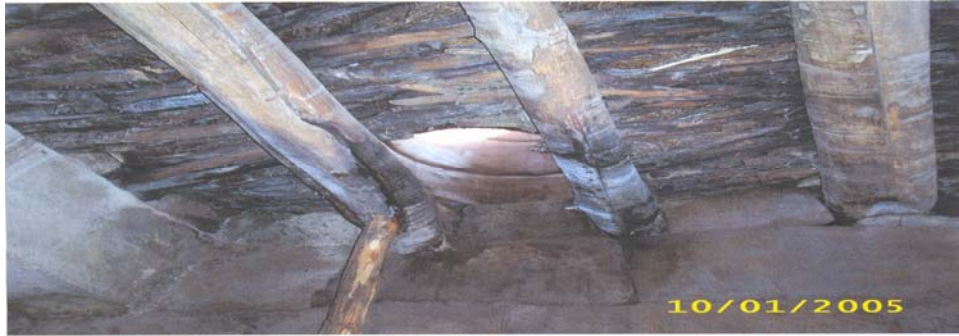
Şekil 4.5 Tavanına daire şeklinde bir baca bulunan tavan ve duvarlarında nem yoğunlaşmasının olduğu bir barınağın içeriden görünümü(Ahlat)
