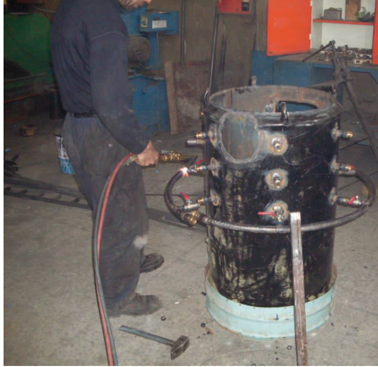
Şekil 5.8. Halka kollektörlerin yanma haznesine montajı
