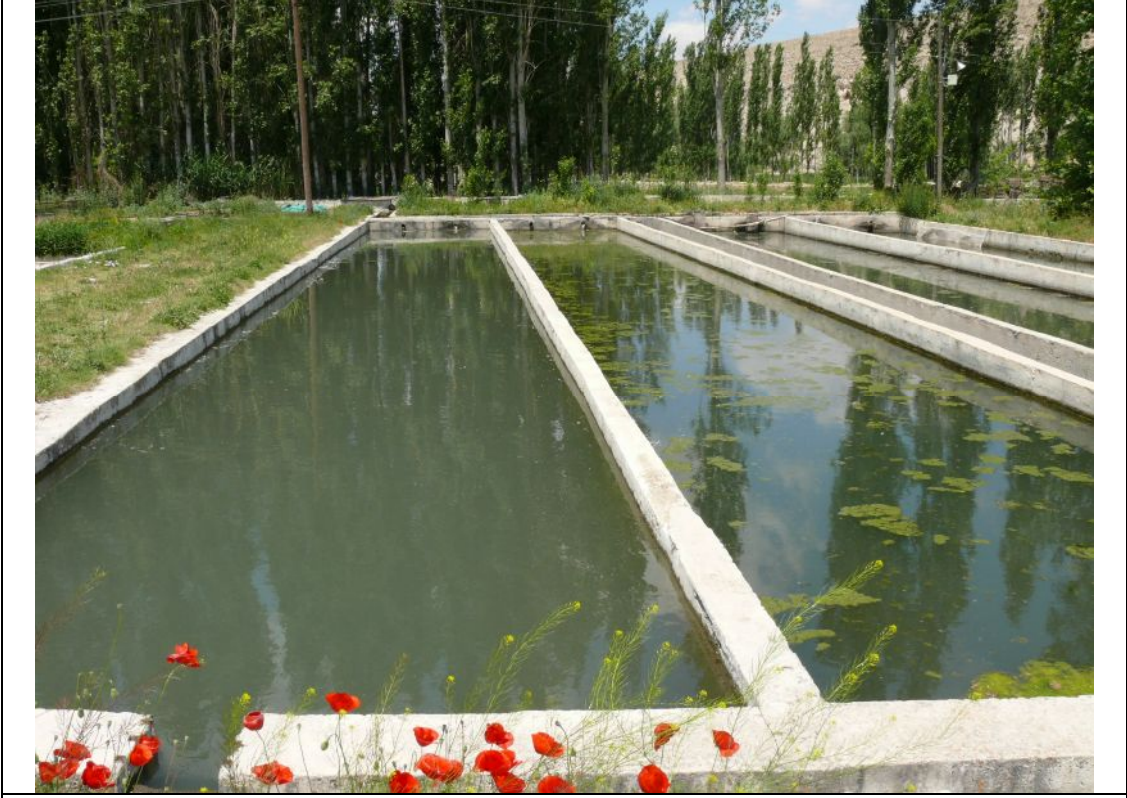
Resim 2.2.1.1. Beton havuzlar, 2 no'lu işletme, Konya.
