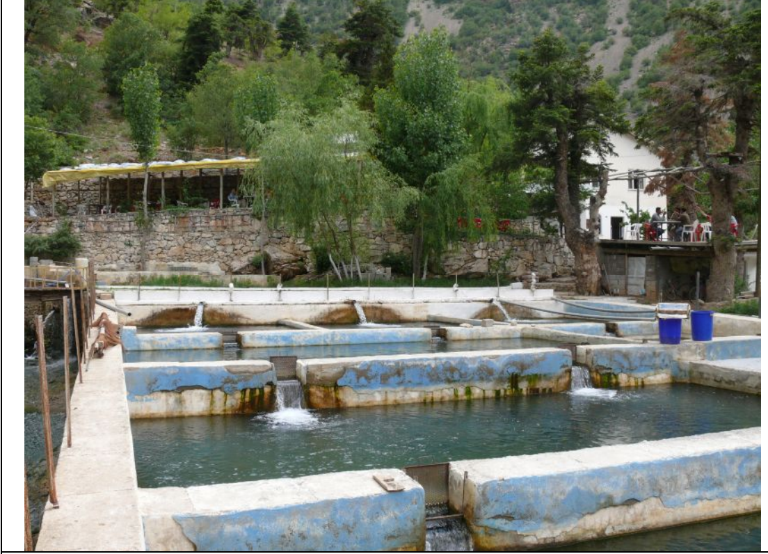
Resim 2.2.1.3. Beton havuzlar, 6 no'lu işletme, Konya.
