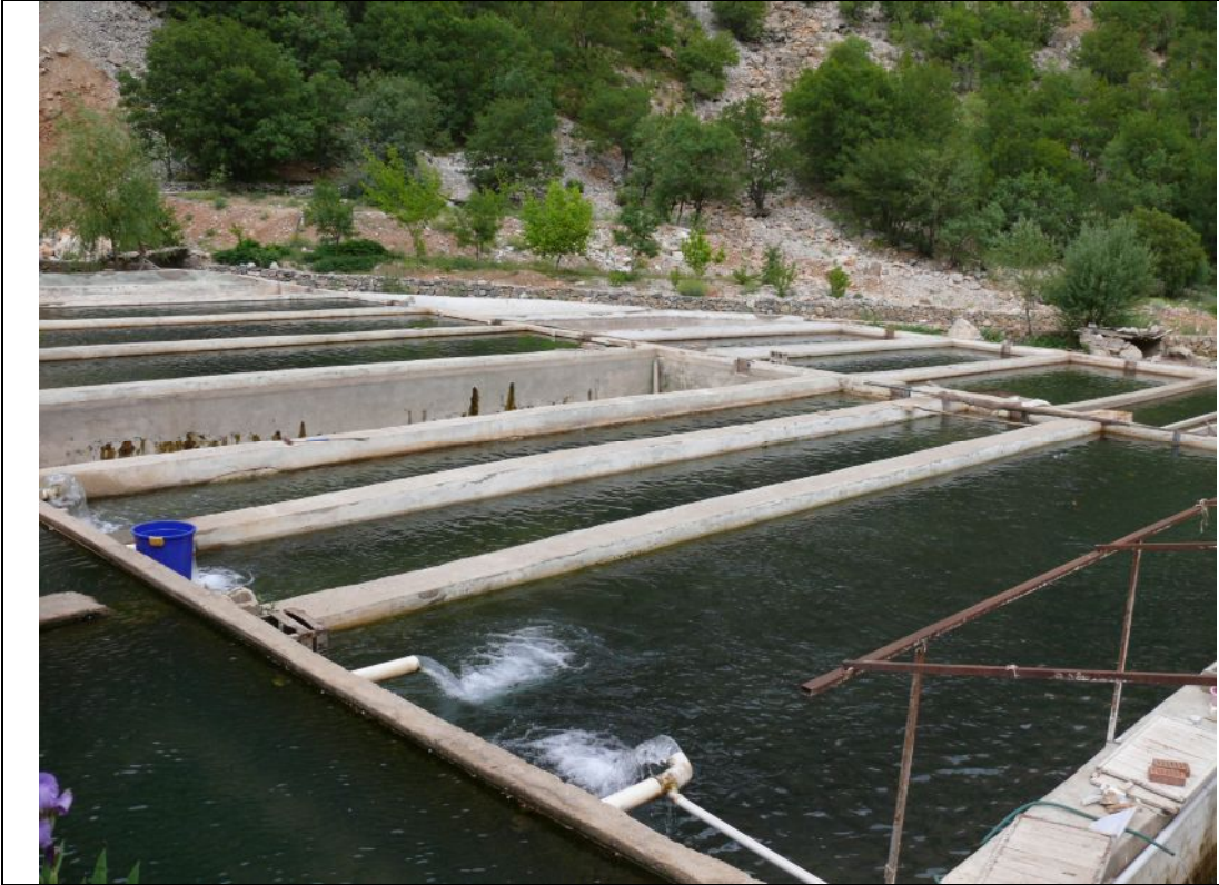
Resim 2.2.1.2. Beton havuzlar, 5 no'lu işletme, Konya.
