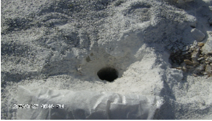
Şekil 3.2: Rockun Deldiği Delik Çapı 89 mm 'dir
