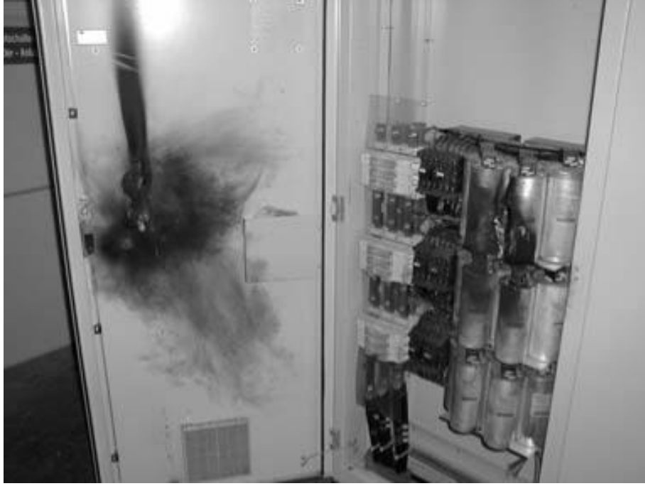
Resim 6.1. İyi kontrol edilmeyen bir sistemde oluşan rezonans sonucu kapasitif elemanların tahribatı (Fassbinder 2003).
