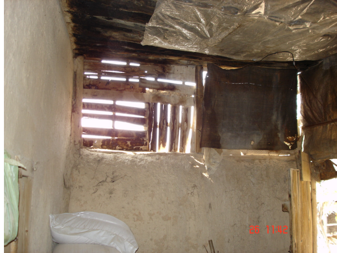
Resim 5.2 Ayşe Turan (Mafazalar) Evi aşanesinin duvarı ve giriş kapısı
