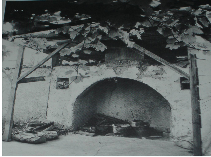
Resim 3.3 Bahçede kazan ocağı (Yahniler Bağ Evi) (Günay 1999)
