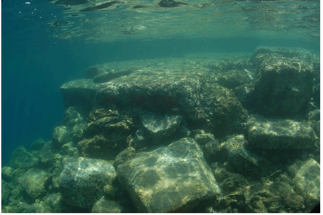
Resim1: Doęu Limanı Mendireęinin Harçlı Zemini ve Mendirek Üzerine Blok Taşlarla Yapılmış Düz Tabandan Bir Görünüm.
