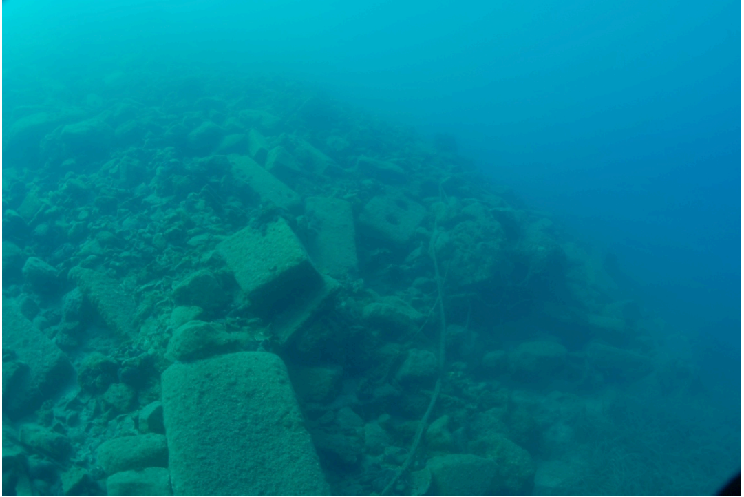
Resim 1: Mendireğin Tabanına Yayılmış Blok Taşlar ve Moloz Yığı.ı.
