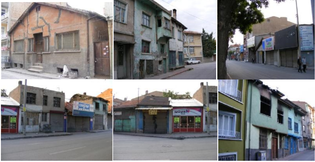
ekil 5.20. Uygulama alanı i levsel açıdan özelli ini yitirmi yapılarla örnekler
