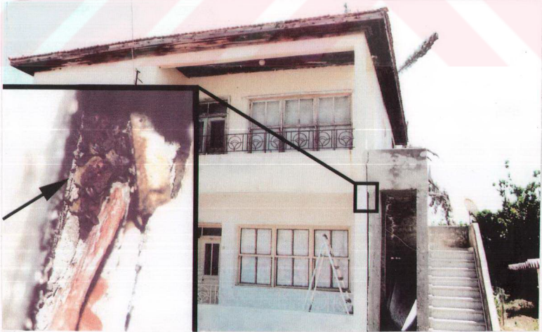
Şekil 4.1. Bir duvar çatlağında bulunan küçük bir P. kuhlii kolonisi
