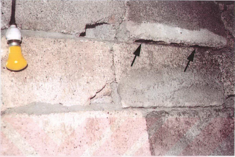
Şekil 4.2. P. kuhlii 'nin bulunduğu bir briket duvar aralığı
