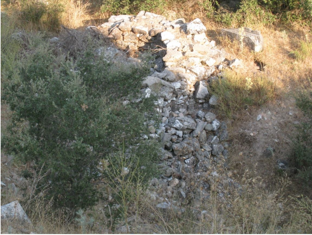
Şekil 17: Tiyatro sahne binası
