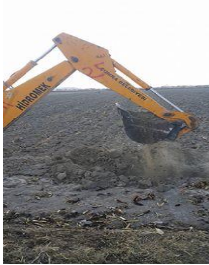
Şekil 3.5. Kepçe ile toprak profili için çukur açılması
