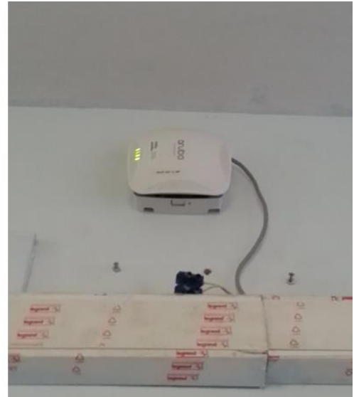
Şekil 5.4 Aruba erişim noktası ve bina içerisinde yerleşimi
