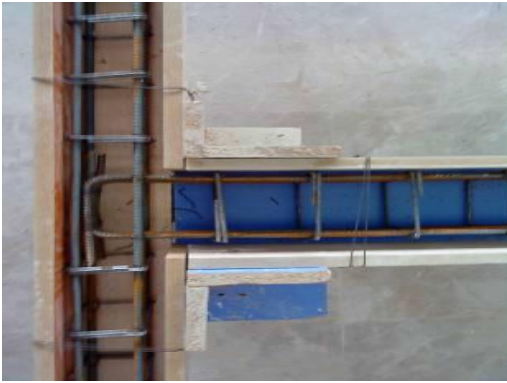
Şekil 3.6. Kolon ve kiriş donatılarının düzenlenmesi
