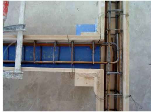
Şekil 3.6. Kolon ve kiriş donatılarının düzenlenmesi
