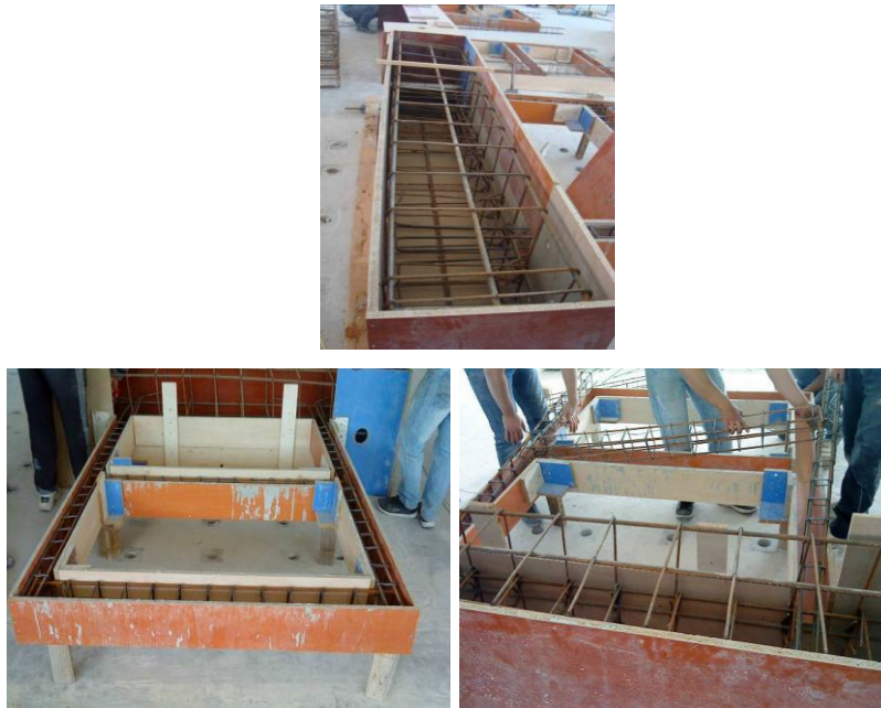
Şekil 3.10. Donatıların hazırlanması ve kalıplara donatının yerleştirilmesi
