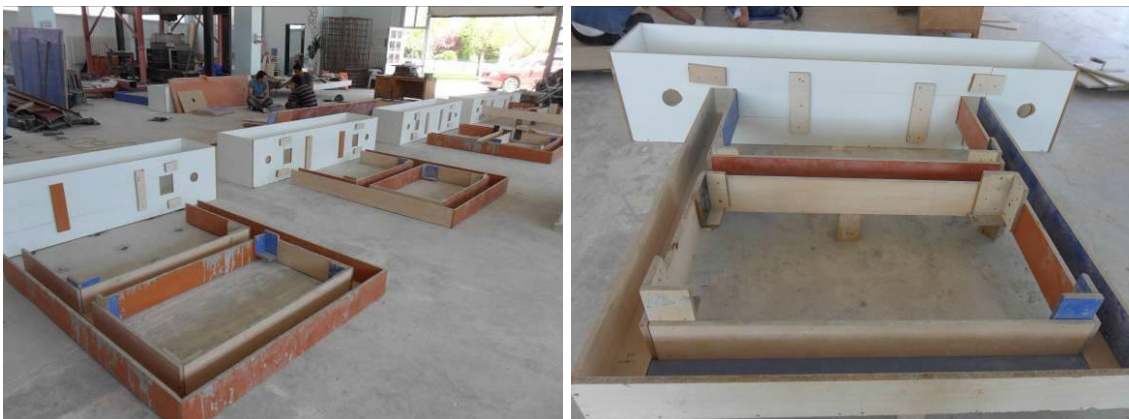
Şekil 3.9. Betonarme boş çerçevelerin hazırlanması
