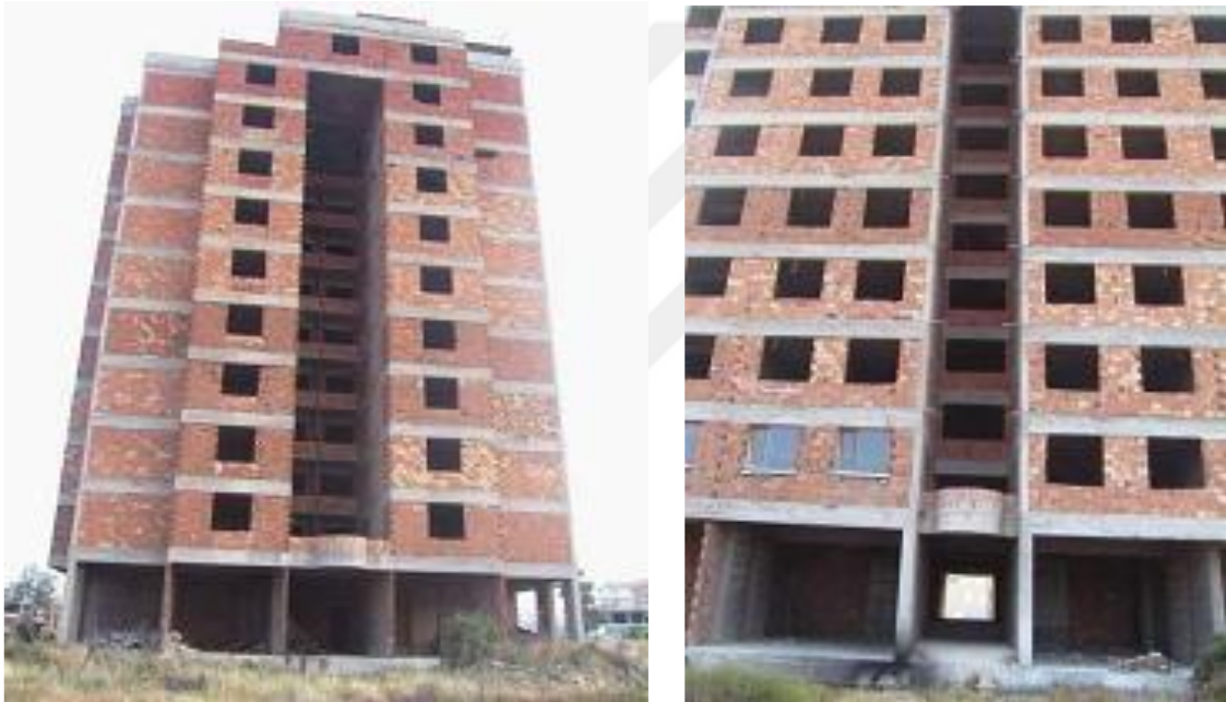
Şekil 1.13. Planda çıkıntı yapmış bina (Sandıkçı, 2014)
