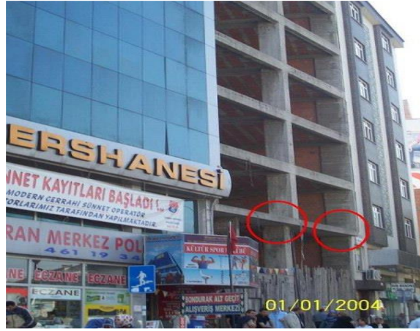
Şekil 1.29. Çakışmayan kolon aksı (Topçu, 2008)
