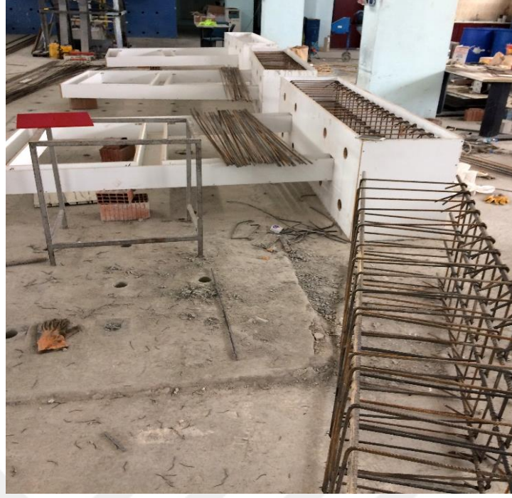
Şekil 3.9. Donatıların hazırlanması
