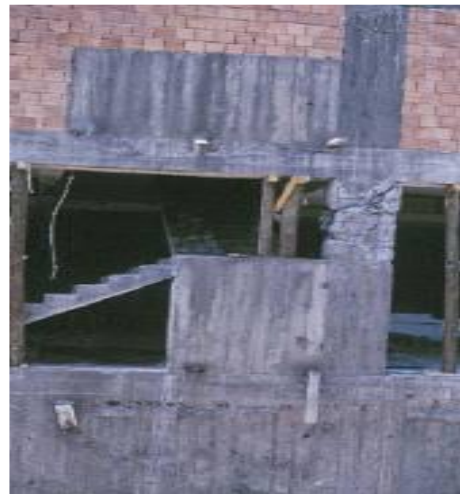
Şekil 1.31. Düşey taşıyıcı elemanların süreksizliği örnekleri (Topçu, 2008)
