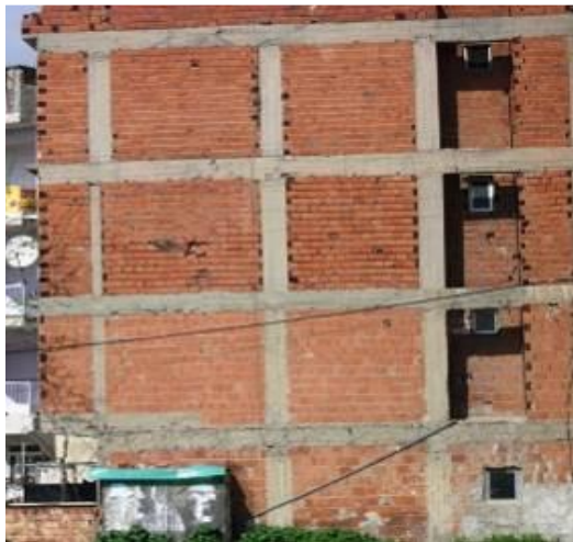
Şekil 1.31. Düşey taşıyıcı elemanların süreksizliği örnekleri (Topçu, 2008)
