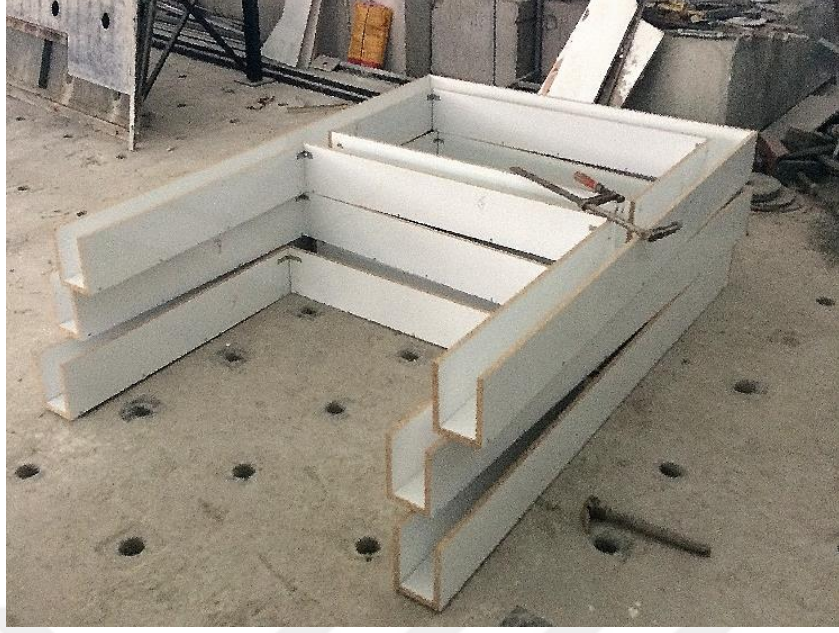
Şekil 3.7. Kalıpların hazırlanması
