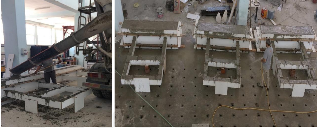
Şekil 3.11. Beton döküm aşaması ve dökümü tamamlanmış çerçeveler
