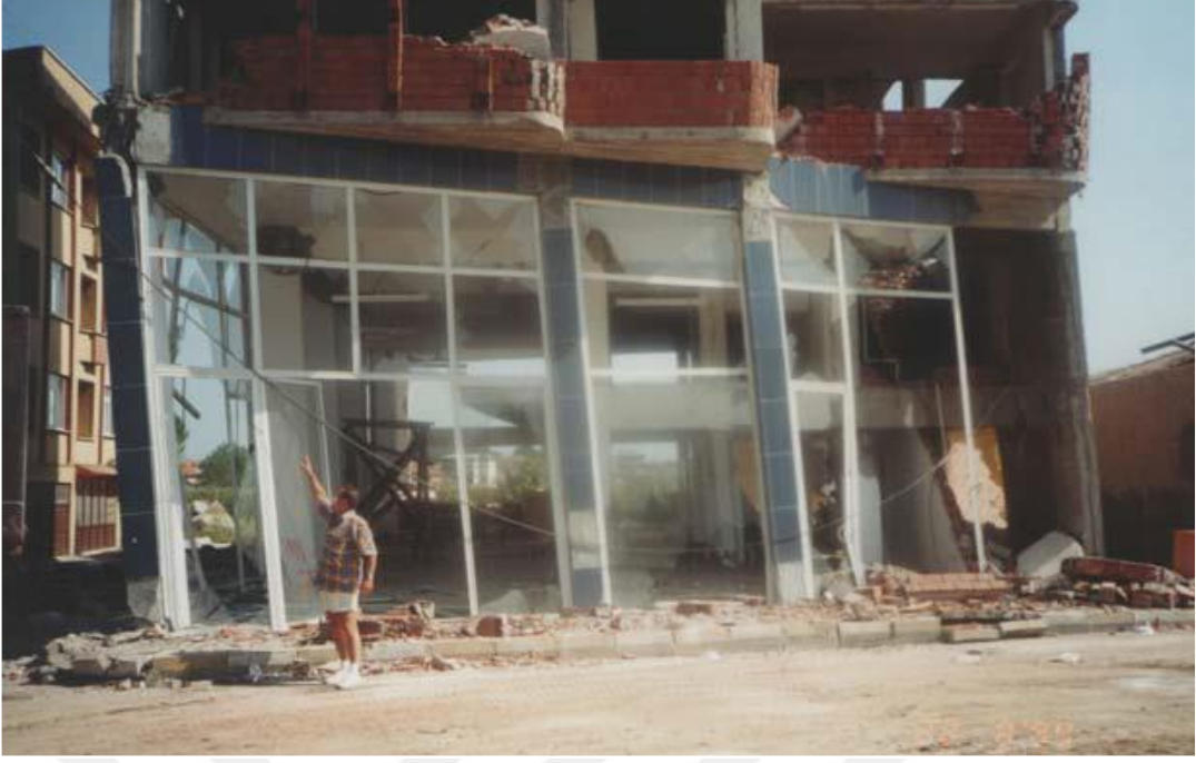
Şekil 1.22. Giriş kat yumuşak kat düzensizliği Örnek-2, 1999 (Tezcan ve ark., 2007)
