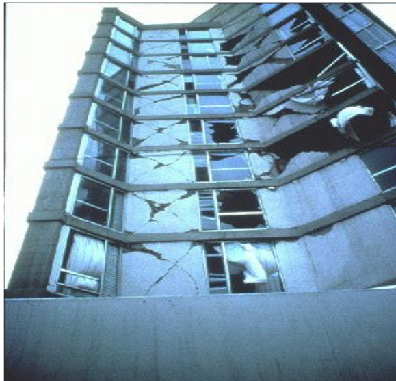
Şekil 1.8. Burulma düzensizliği hasarı (Topçu, 2008)
