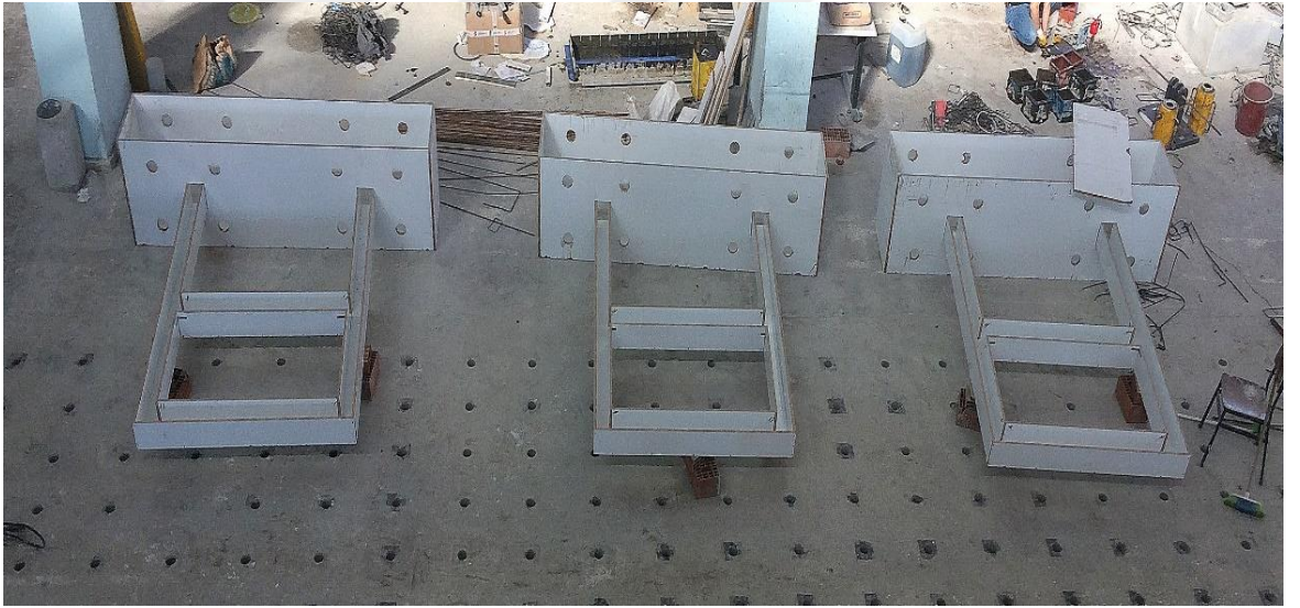
Şekil 3.8. Kalıp montajı tamamlanmış çerçeveler
