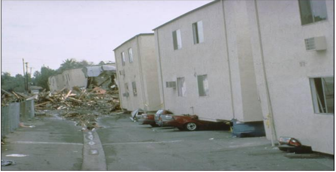
Şekil 1.21. Giriş kat-yumuşak kat düzensizlięi Örnek-1 (Topçu, 2008)
