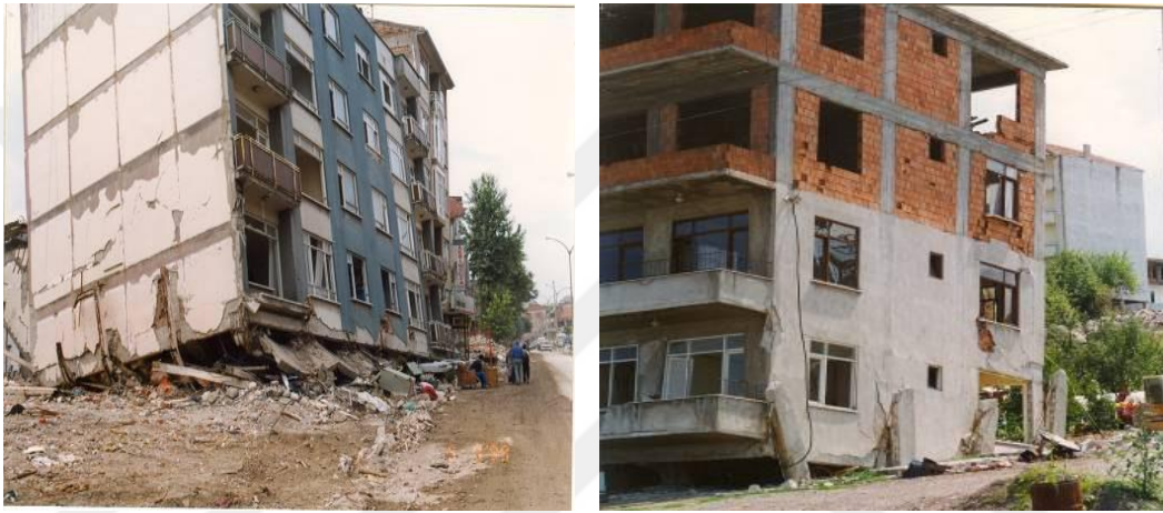
Şekil 1.24. Giriş kat yumuşak kat düzensizliği Örnek-3 ve 4,1999 (Topçu, 2008)
