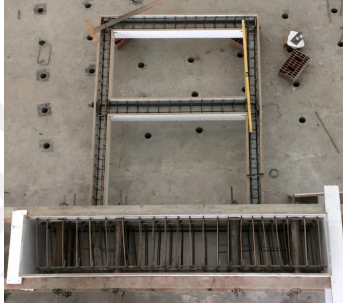
Şekil 3.3. Donatı montajı tamamlanmış çerçeve deney numunesi
