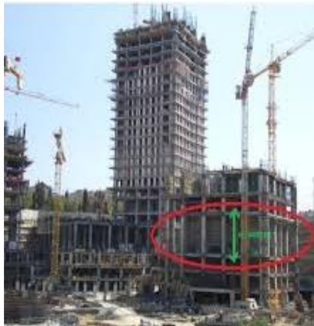
Şekil 1.27. Ara katta yumuşak kat düzensizliği örneği (Özürün, 2014)
