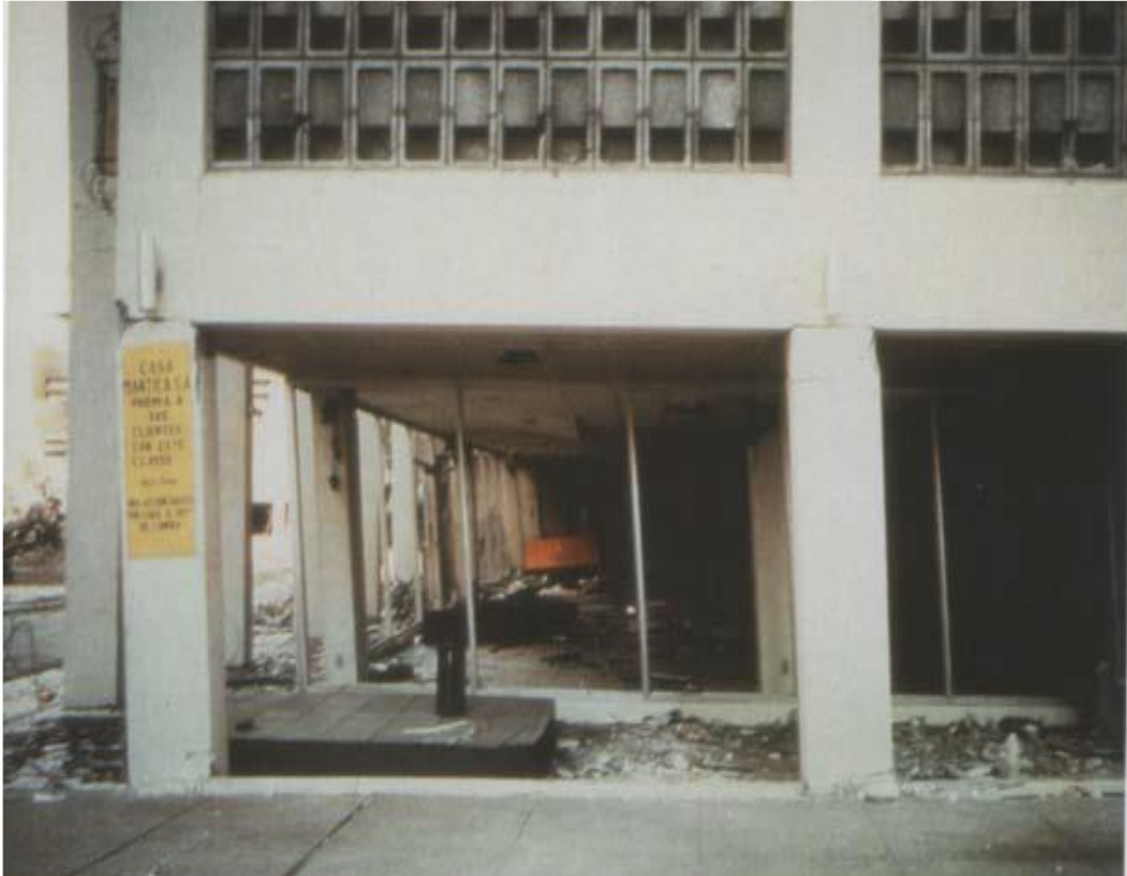
Şekil 1.19. Casa Micasa binası zayıf kat hasarı, 1972 Nicaragua depremi, M = 6,2 (Tezcan ve ark., 2007)
