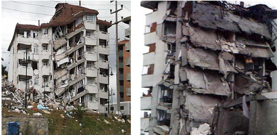
Şekil 1.10. Döşeme süreksizliđi nedeniyle hasar görmüş yapılar (Sandıkçı, 2014)
