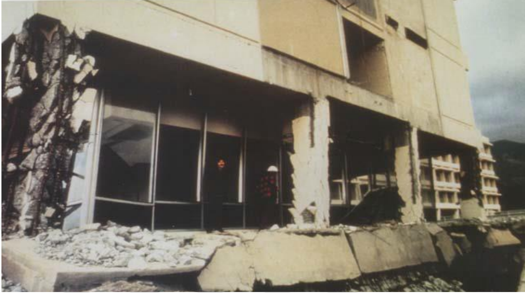
Şekil 1.26. Olive View hastanesi yumuşak kat ve zayıf kat hasarı, 1971 Kaliforniya Depremi, M = 6,5 (Tezcan ve ark., 2007)
