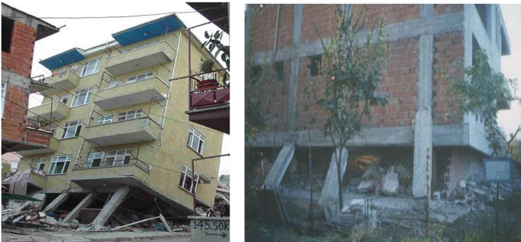
Şekil 1.25. Giriş kat yumuşak kat düzensizliği Örnek-5 ve 6,1999 (Sandıkçı, 2014)
